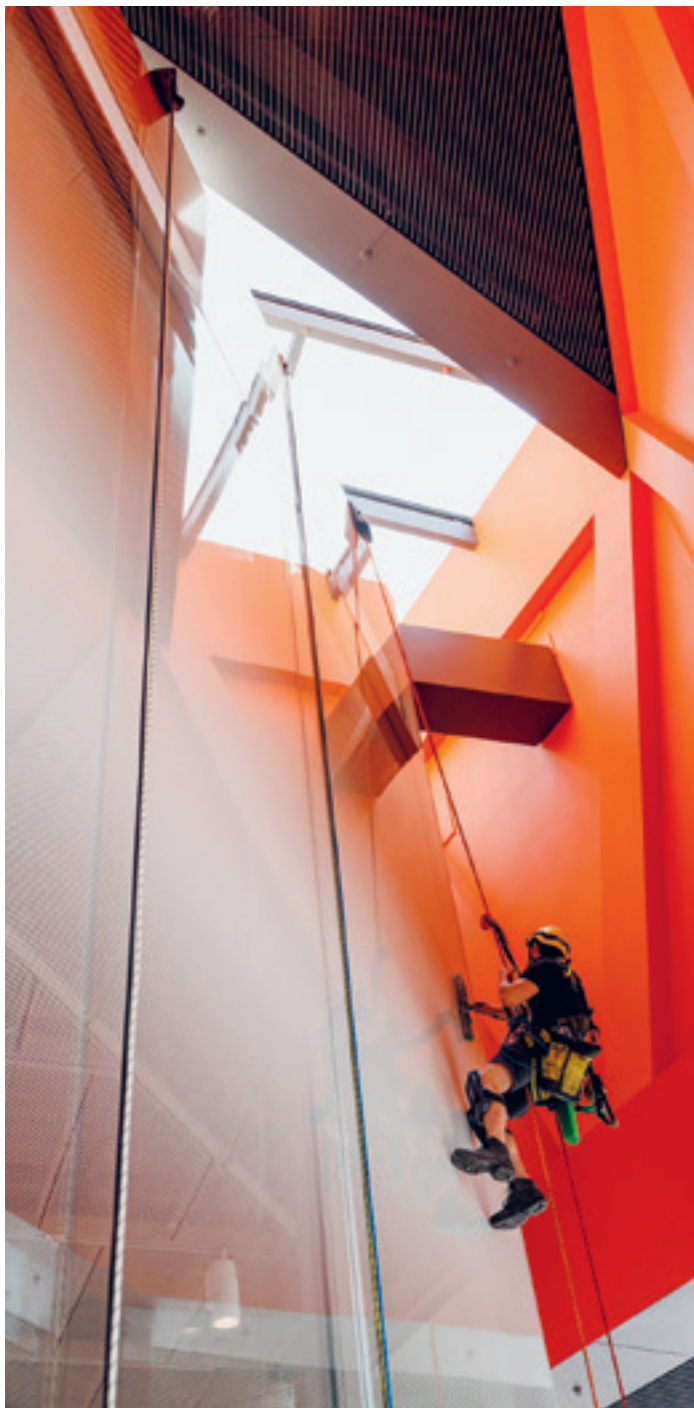
Das geht hoch hinaus: Einmal im Jahr wird die großflächige Verglasung der Studios gereinigt – bis in eine Höhe von 30 Metern.
